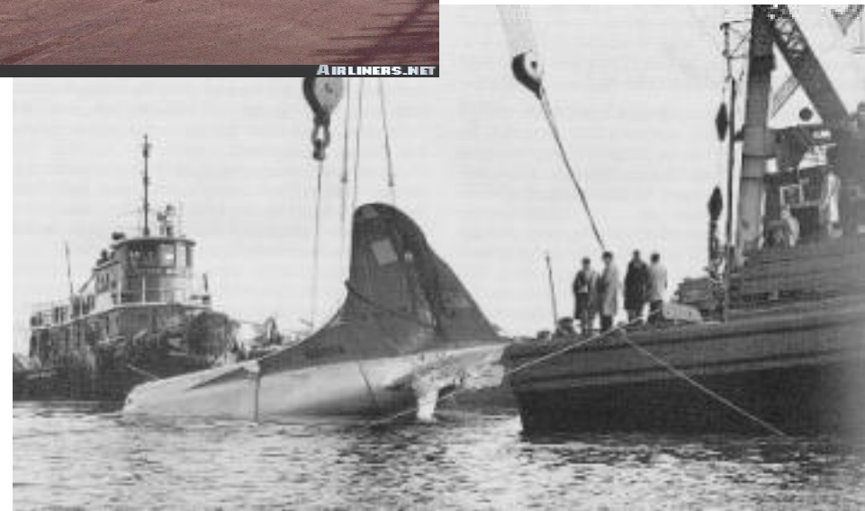
Samolot Lockheed L-188 „Electra” ...po wypadku spowodowanym flutterem wirowym (1960)
